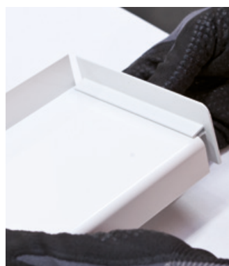
Montage der seitlichen Alu-Abschlüsse
