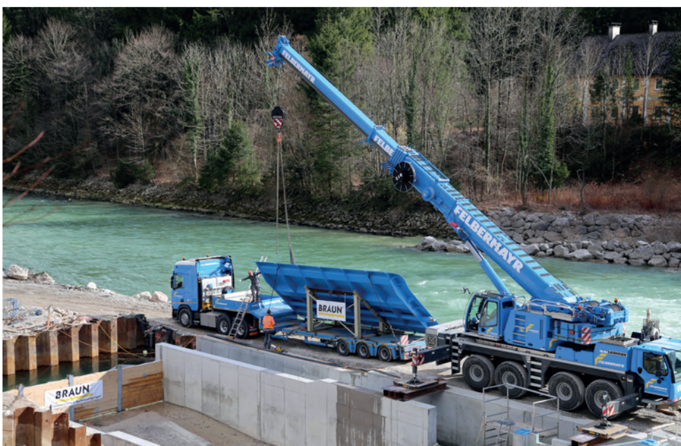
Die bis zu zehn Tonnen schweren Klappen wurde von der Firma BRAUN Maschinenfabrik GmbH gefertigt. Eine reguliert den Zufluss in den Betonkanal, die zweite erzeugt die quasi endlos surfbare Welle.
