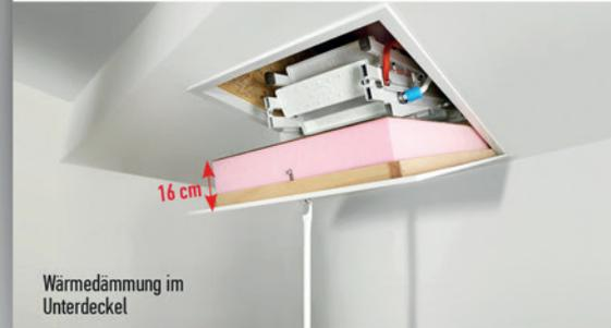
Wärmedämmung im Unterdeckel
