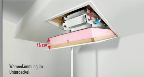
Wärmedämmung im Unterdeckel
