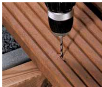
Diele und Holzunterkonstruktion mit Holzbohrer Ø 3,5 mm vorbohren.
