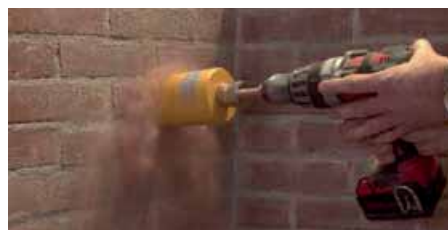
Sägen in Mauerwerk
