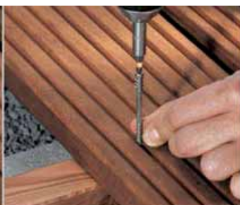
SPAX®-D gerade ansetzen. Ohne unterbrechung kopfbündig verschrauben.
