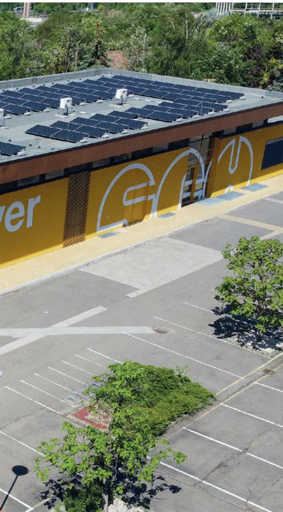
das gesamte Dach des Gebäudes zielt. Mit der Anlage, die im Mai erfolgreich in Betrieb genommen wurde, kann somit der jährliche Strombedarf gedeckt werden. Eingebaut wurden zwei Stück je 25 kW Inverter „Solaredge“ und insgesamt 182 Solarpaneele „Hyundai“ mit je 410 Wp Leistung.
