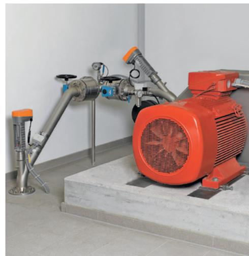
Trinkwasserpelton-turbine mit eindüsigem Zulauf mit Bypass für stetig garantierten Wasserdurchfluss.
