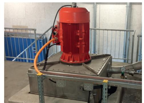
Pelton-turbine eindüsig Trinkwasserkraftwerk mit 24KW in vertikaler Bauweise.
