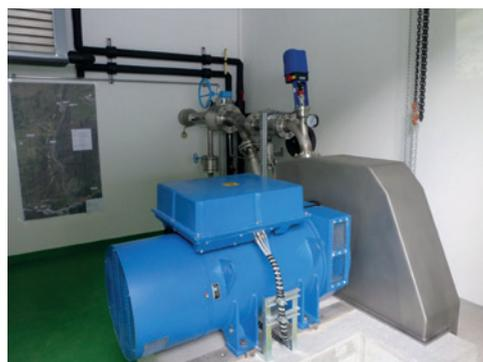
Pelton-Turbine zweidüsig Kraftwerk mit 246KW in horizontaler Bauweise.
